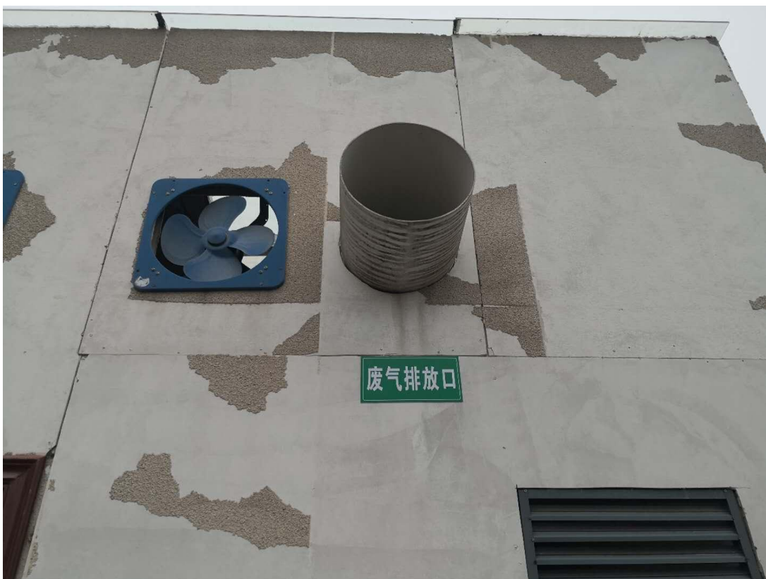
废气排放口标识
