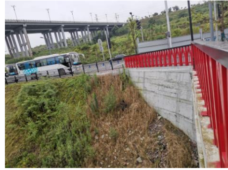
起点接双辉路左侧挡土墙
