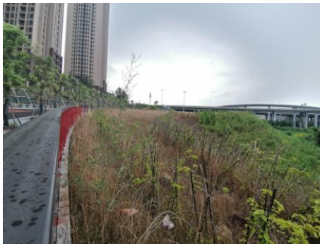
图 7.7 回填区坡面绿化恢复
