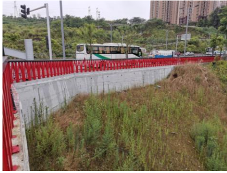
起点接双辉路右侧挡土墙
